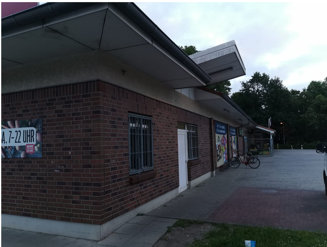
Abbildung 4: Haupteingang des REWE-Marktes, Blick nach Osten auf das Gehölz
